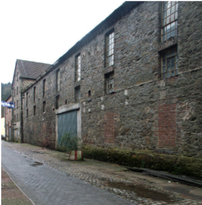
Abb. 6 Ansicht der zur Kammzugfärberei umgebaute Flügel. Entnommen aus: (Dominick, Peter - S.51)
