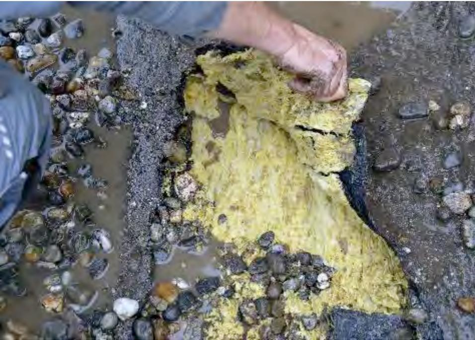
Bitumendeckung auf Mineralwolle, verklebt
