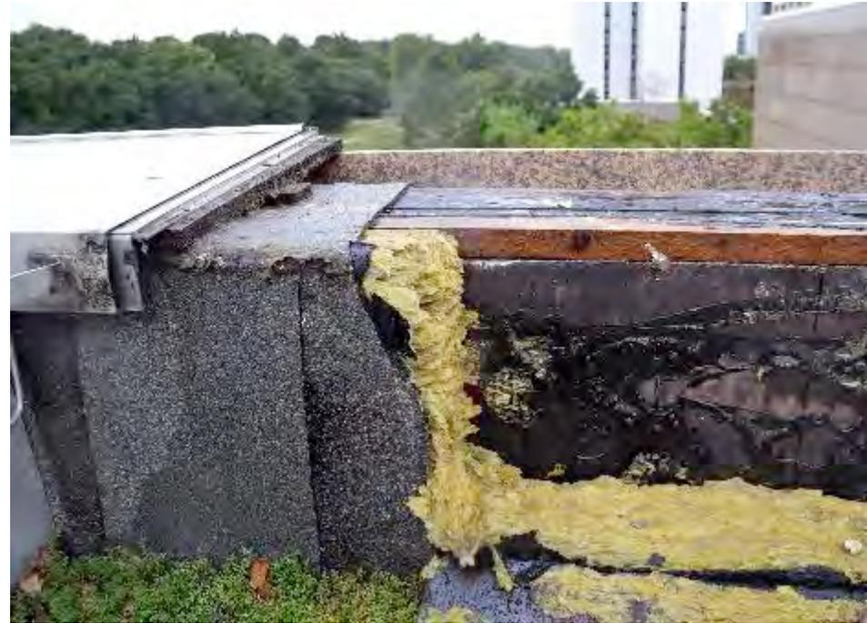
Attika, Stahlbeton mit Bitumen verunreinigt
